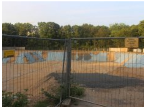
Große Baugrube: Hier soll die Longericher Gesamtschule entstehen.
